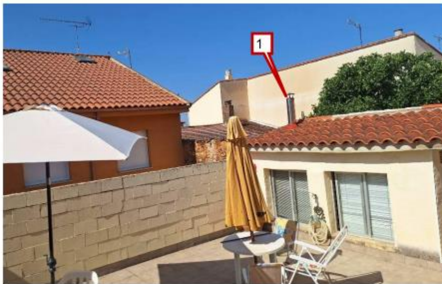
Cuarto de caldera y chimenea desde el patio de la interesada
