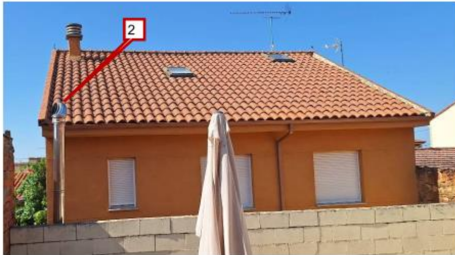
Patio y fachada posterior vista desde el patio de la interesada con la chimenea.
