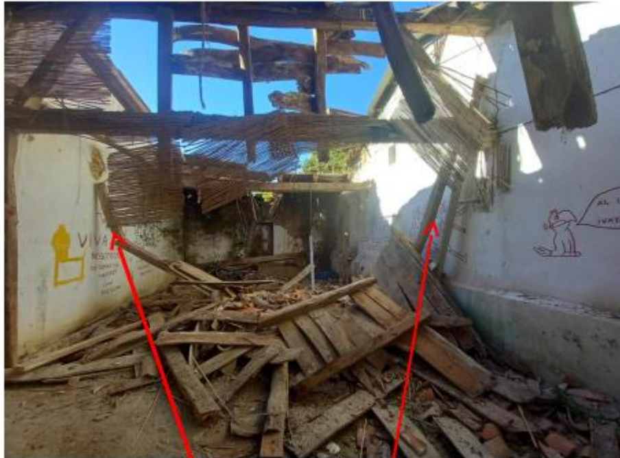
POSIBLES VIGAS POR DONDE PUEDEN ENTRAN Y SALIR LOS GATOS SIN DIFICULTAD
