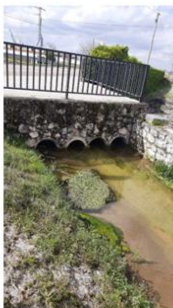
Vista aguas arriba
