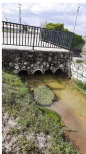
Vista aguas arriba
