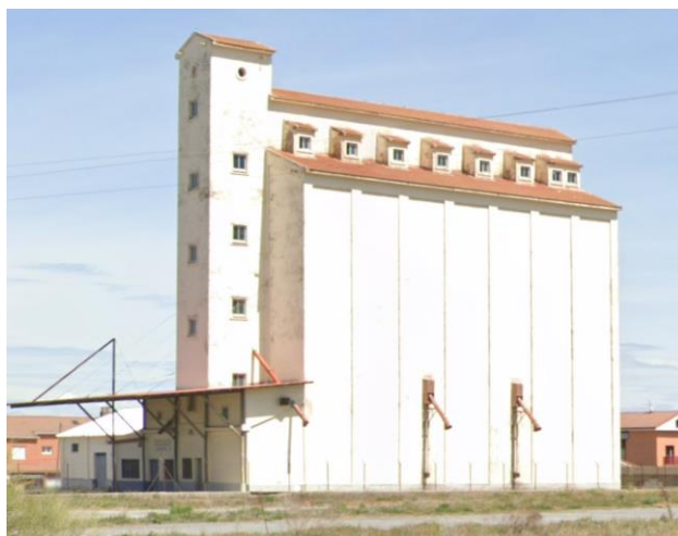
Silo de Tudela de Duero (Valladolid) (Fotografía obtenida de la aplicación Google Maps, abril de 2023)
