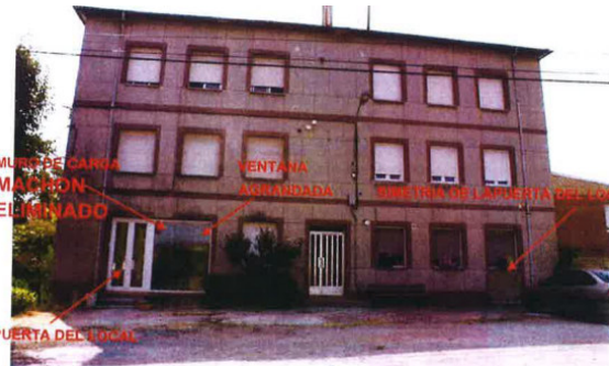
FOTO Nº10 Vista de la Fachada después de las obras en el muro de carga
