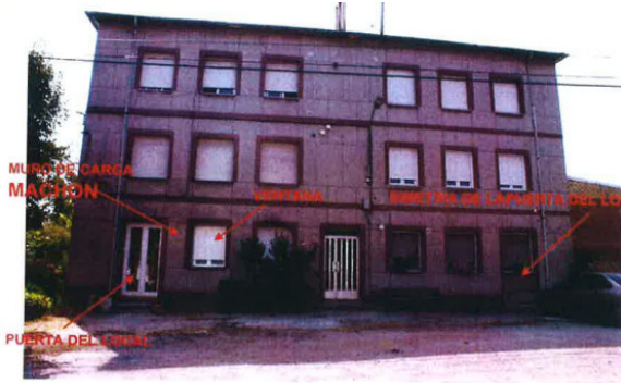
FOTO Nº9 Vista de la Fachada antes de las obras en el muro de carga
