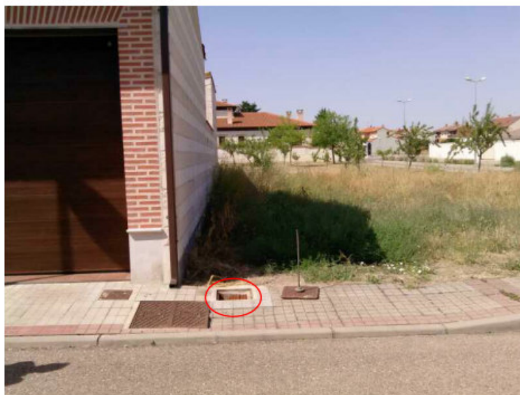
Situación de la arqueta del contador.
