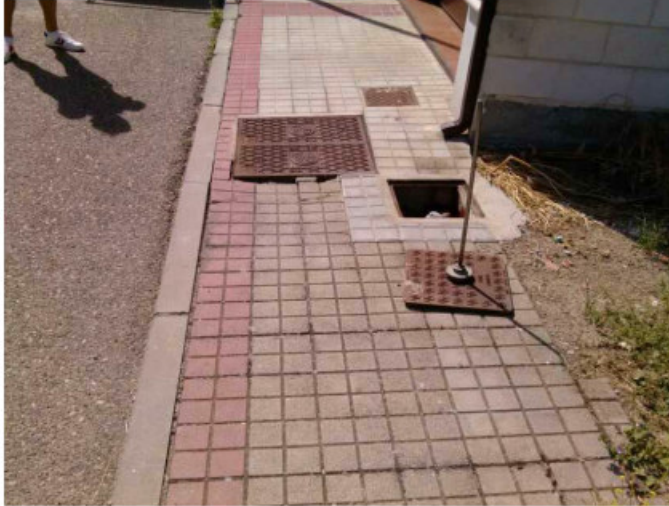
Situación del contador.
