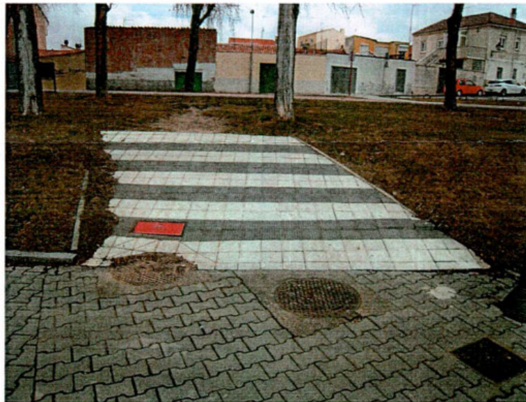
RAMPA NO ACCESIBLE INICIADA DESDE SECTOR 3. ZONA DE CÉSPED EROSIONADA. AL FONDO, ZONA DE LA FOTO ANTERIOR
