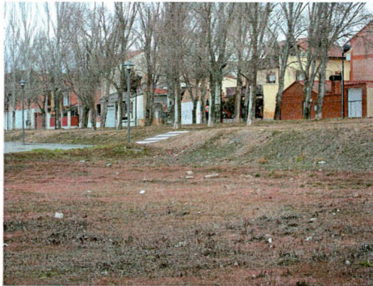
VISTA LEJANA DEL LUGAR, EN QUE SE APRECIA LA BARRERA URBANÍSTICA QUE CREA EL CANAL DE PALENCIA
